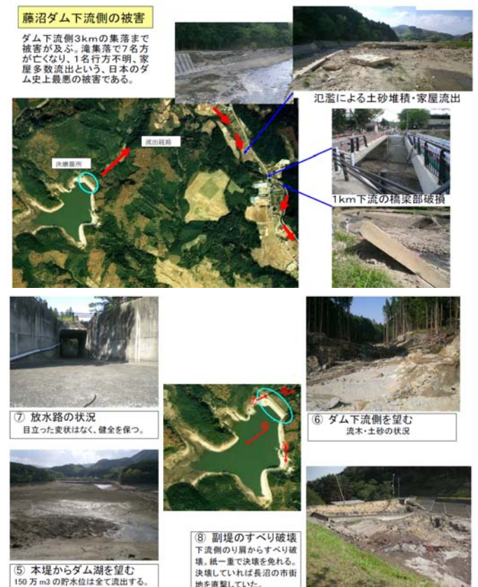
図 9 藤沼ダム下流側等の被害状況
