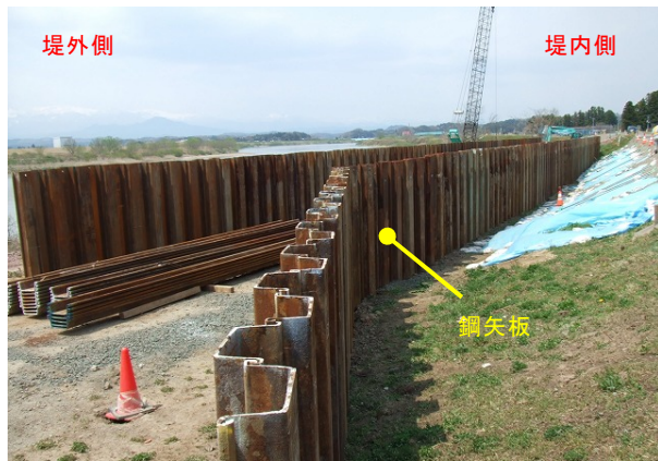
写真6 鋼矢板二重締切りによる仮堤
