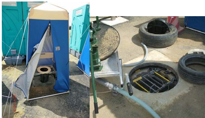
写真4 仮設トイレの設置事例 (注) 右：洋式型トイレ、左：フラッシュ用マンホール
