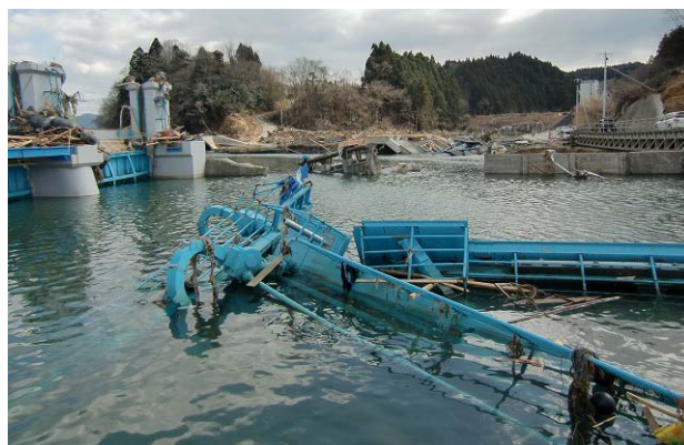
写真7 操作橋・管理橋の流出
