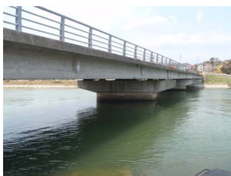
写真-5 浜畑橋の状況
