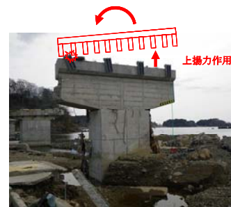
図 21 P7 橋脚上の桁流失メカニズム
