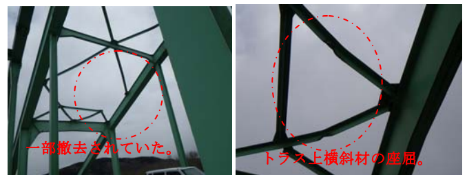
図9 トラス上横斜材の座屈
