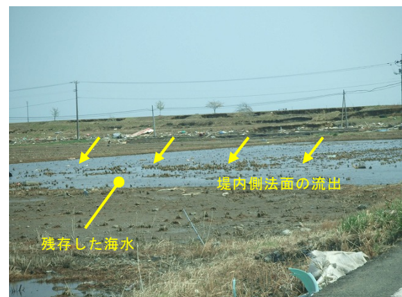
写真1 堤防法面の流出
