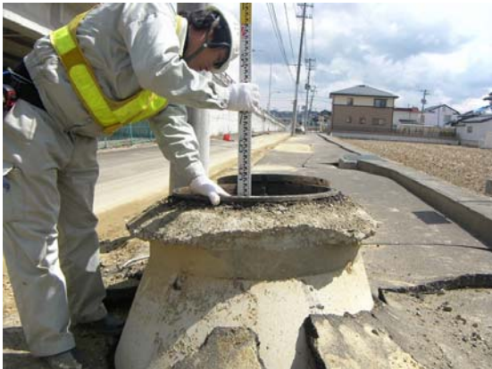
災害査定設計へ向けた下水道管路の調査の様子
