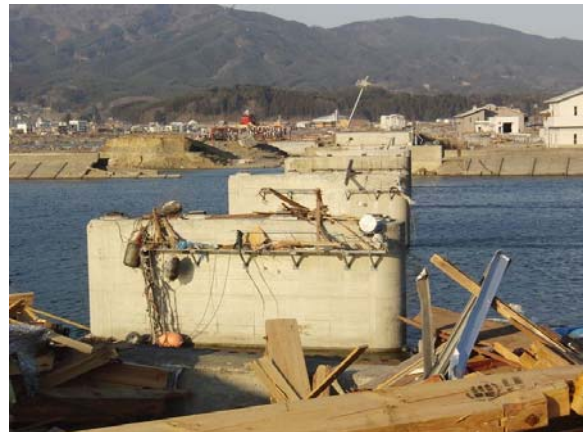
写真 13 気仙大橋 (起点側より撮影)
