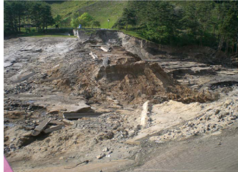
図 10 藤沼ダム堤体の被害状況
