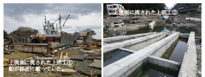
図15 上流側に流されたPC桁
