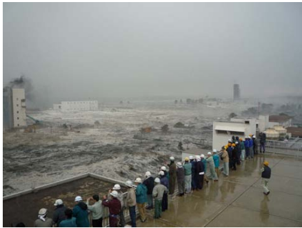
写真7 津波による南蒲生浄化センター —浸水状況(仙台市 Web)
