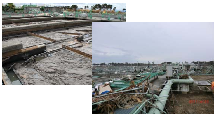
図6 津波被害を受けた処理場の事例(宮城県内)
