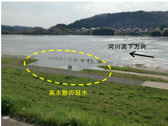
写真12 高水敷の冠水状況
