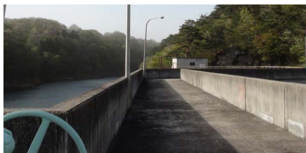
写真14 堤体天端(軸線が折れている)
