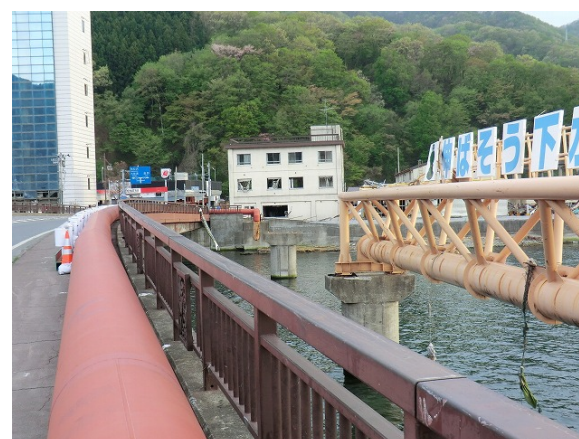
写真3 水管橋暫定機能確保の事例（釜石市） （注）右が流出した独立水管橋
