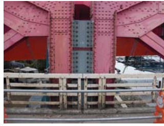
写真14 桁連結工
