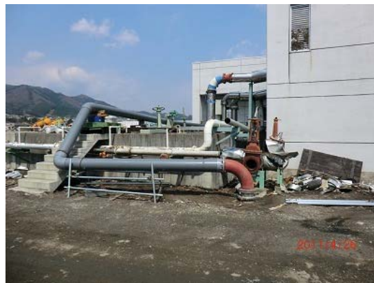
図 11 流入ポンプ棟からの仮配管（大船渡市）
