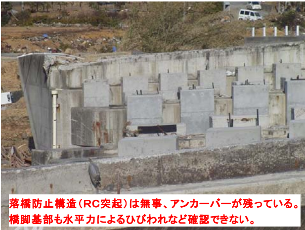
写真 11 沼田跨線橋 橋台背面から橋脚を撮影 (8)川原川橋 (陸前高田市)
