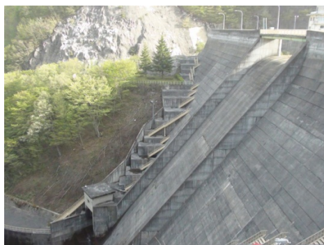
写真13 岳ダムの堤体下流側
