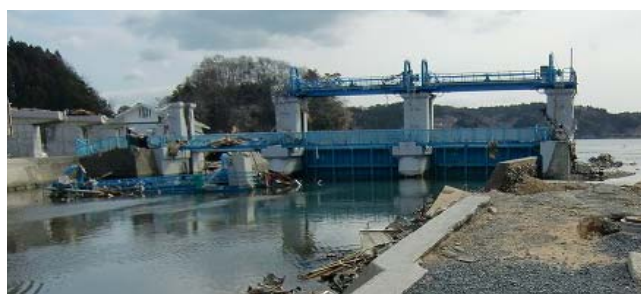
写真1 歌津川河口付近の防潮水門
