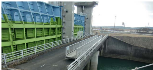
写真11 撤去された操作橋
