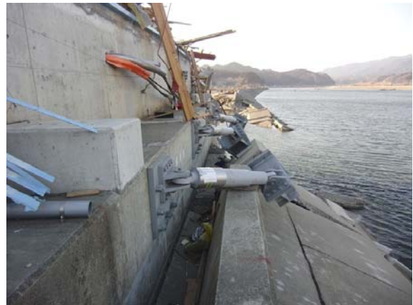
写真 12 気仙大橋 A1 橋台 前面の状況
