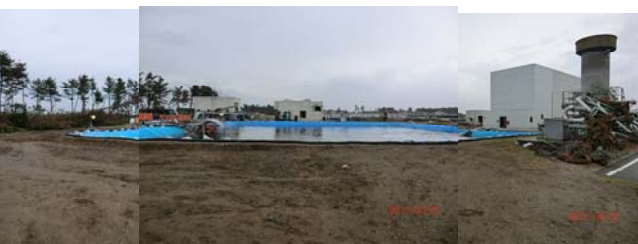
図 9 場内に設けた仮設沈殿池（宮城県内）
