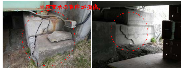
図7 支承の損傷
