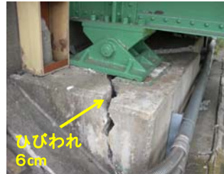
写真2 橋台固定支承部
