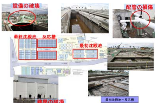
図1 蒲生浄化センター被災状況
