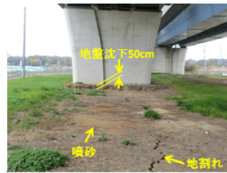
写真21 液状化痕跡
