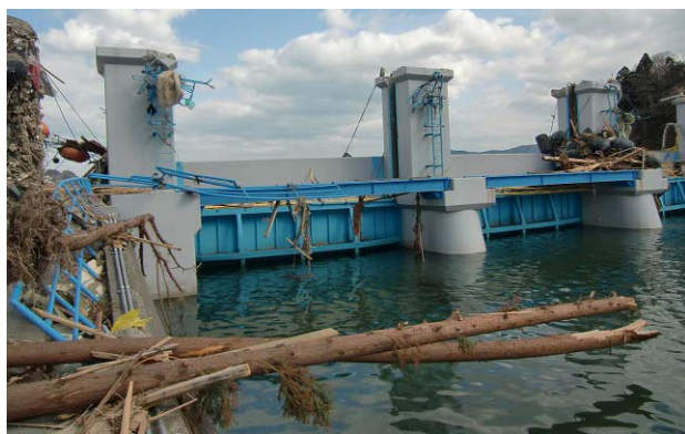
写真5 水尻川河口付近の防潮水門
