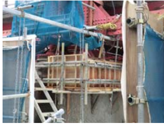
写真16 復旧作業状況
