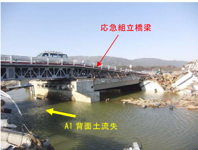
写真 11 川原川橋 応急橋梁による交通確保 (9)気仙大橋 (陸前高田市)
