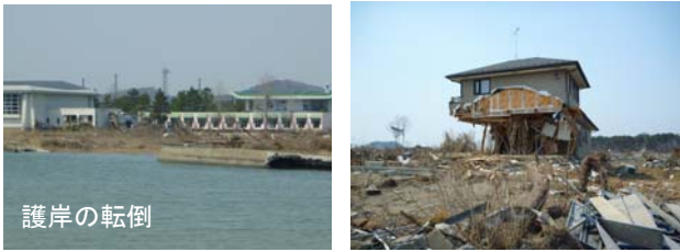
写真5 護岸の転倒と木造家屋破壊の状況
