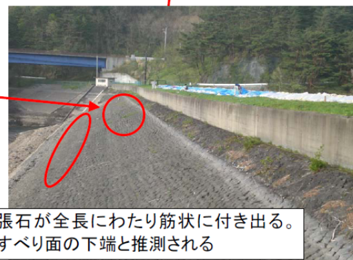
図6 ミツ森ダム堤体被害状況
