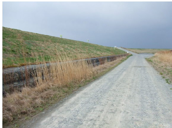
写真13 鳴瀬川右岸 13.1k 地点の状況
