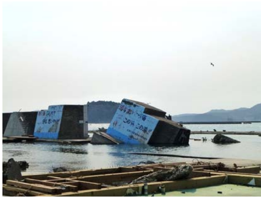
写真 3 海岸施設の被災状況 (南三陸地区)
