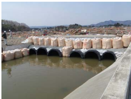
写真-4 釣師橋応急復旧状
