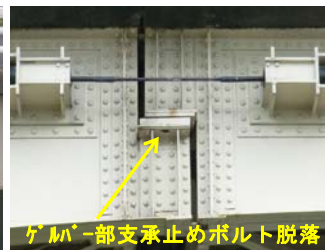
写真12 支承部損傷
