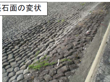
図6 ミツ森ダム堤体被害状況
