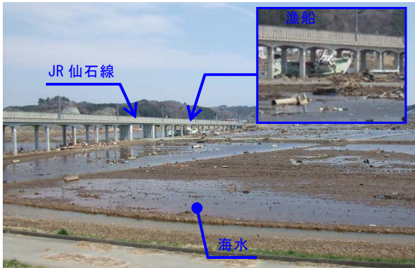
写真 2 国道 45 号南側の区域
